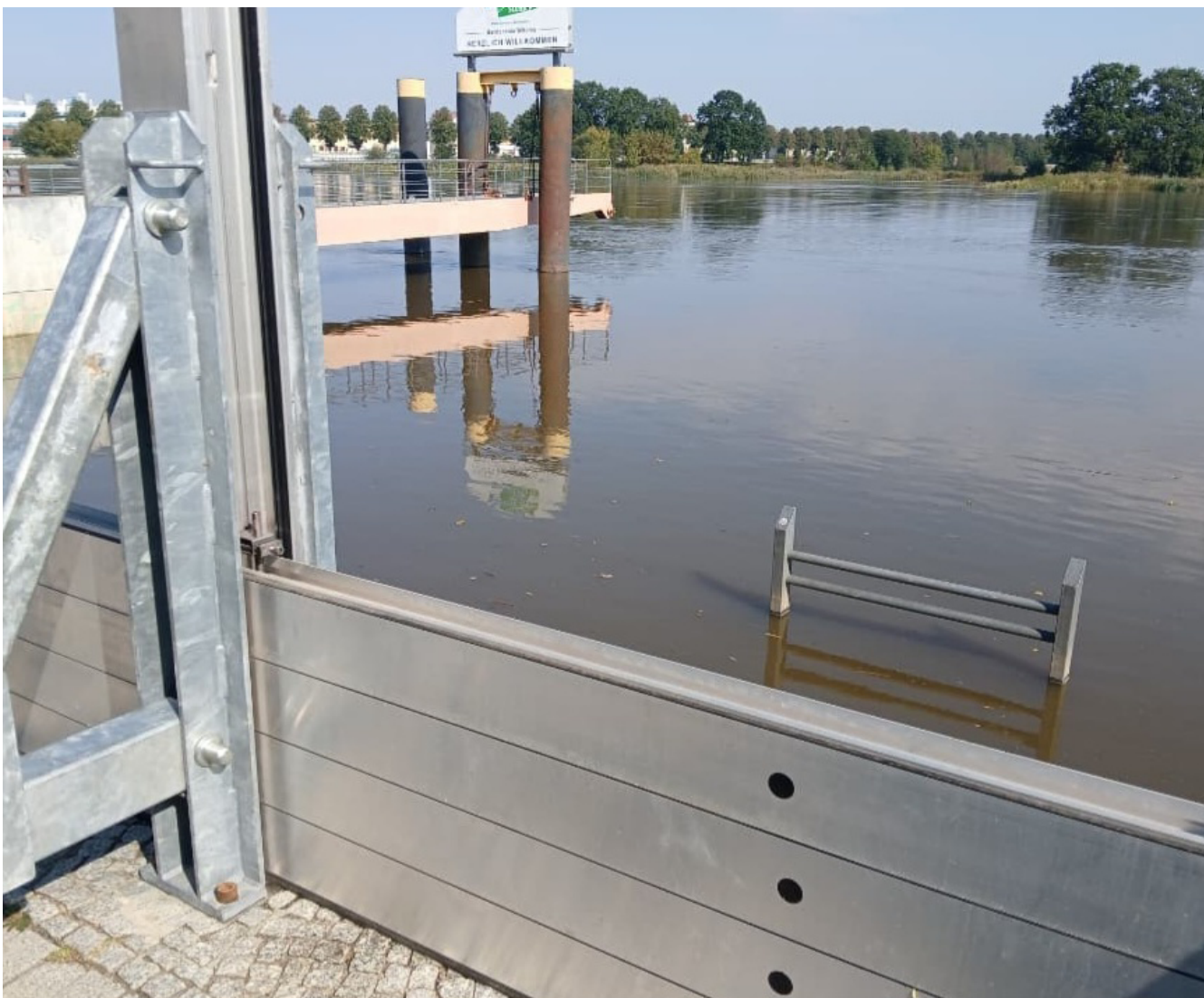
Abb.3: Flutwände hinter dem Museum am Oderufer
