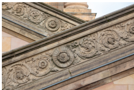
Abb.2: Brüstungsplatten der Freitreppe
