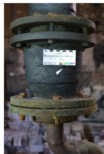
Abb. 3: mit Bitumen getränkte Gewebehinden als Korrosionsschutz
